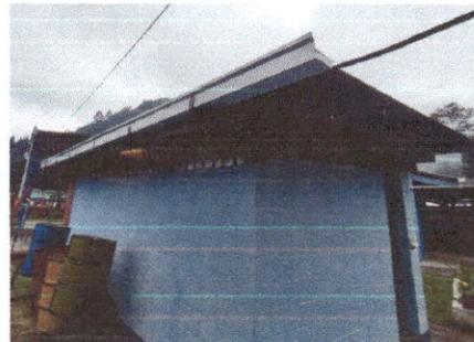
Foto 4: Sustitución de canales de metal con sus respectivas bajadas de agua pluvial
