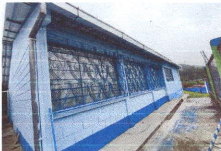
Foto 1: Fundición de 5 columnas de refuerzo para esta aula, una solera sobre los ventanales y reparación de los ventanales con sus vidrios
