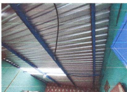
Foto 5: Colocación de laminas troqueladas aluzin calibre 26
